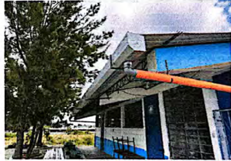
Foto 10: Canal pluvial de alto caudal.
