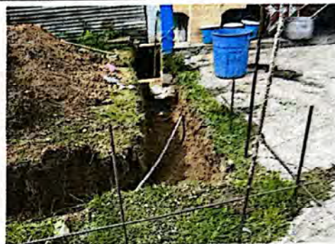
Foto 2: Zanqueo para cimentación de muros.
