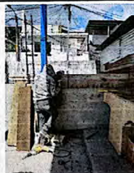
Foto 4: Encofrado y fundición de solera intermedia.
