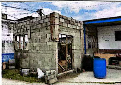
Foto 6: Levantado de muros.
