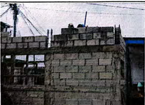
Foto 5: Levantado de Muro.
