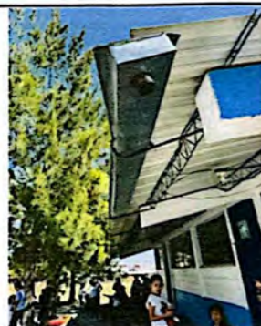
Foto 10: No se cuenta con bajadas de agua en el Módulo A.
