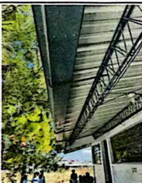
Foto 9: Módulo A el canal presenta abolladuras, y los soportes empleados no cumplen con su función por lo que se deberá realizar el mantenimiento correspondiente
