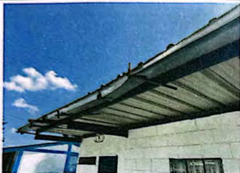
Foto 7: El módulo B cuenta con canales perforados por oxidación y con abolladuras por el paso del tiempo, por lo que ya no son funcionales.
