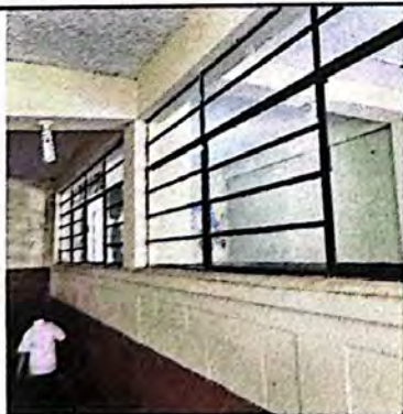
Foto 5: Las ventanas presentan problemas de oxidación por lo que se han quedado bloqueadas.
