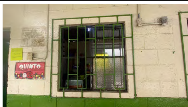
Foto 8: Balcones de ventanas
