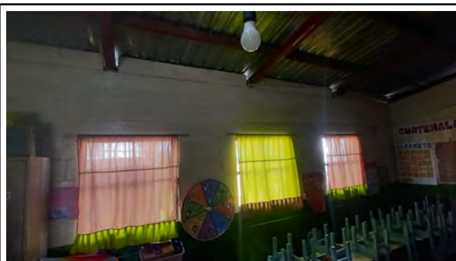
Foto 10: Vista interior de aula
