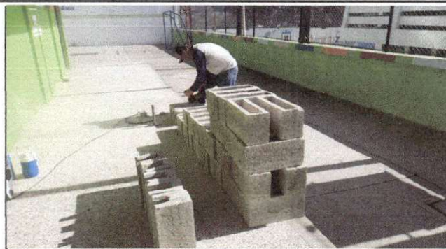
Foto 2: Material de construcción para ampliación de cocina de Escuela Oficial Urbana Mixta "20 de Octubre" J.V.
