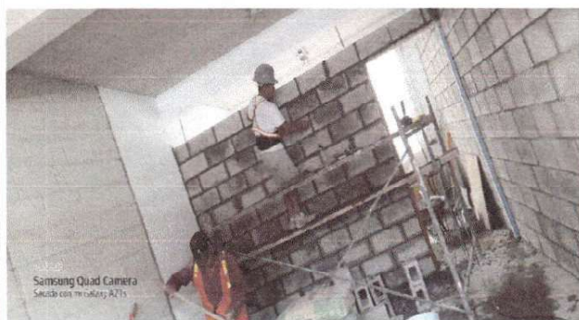
Foto 3: Construcción de pared para ampliación de cocina de Escuela Oficial Urbana Mixta No. 34 "20 de Octubre" J.V.
