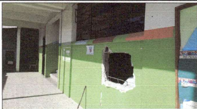
Foto 1: Abertura de pared para instalación de puerta de ampliación de cocina de Escuela Oficial Urbana Mixta No. 34 "20 de Octubre" J.V.
