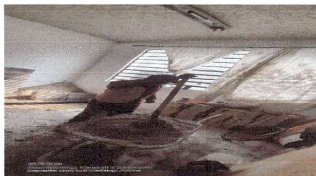
Foto 4: Preparación de material para instalación de azulejo de ampliación de cocina de Escuela Oficial Urbana Mixta No. 34 "20 de Octubre" J.V.
