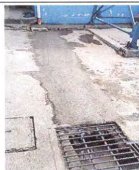
Foto 12: Se modificaron las bajadas de agua para evitar mantener el área húmeda y resbalosa.
