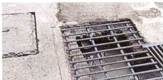
Foto 21: Mantenimiento de drenajes.
