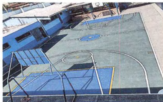
Foto 20: Aplicación de pintura en cancha y marcaje.
