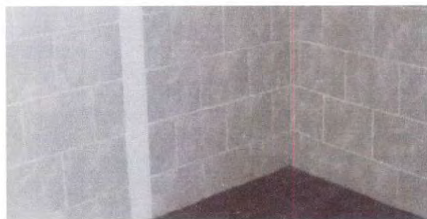
Foto 6: Se colocó azulejo para poder mantener una adecuada higiene en la cocina.
