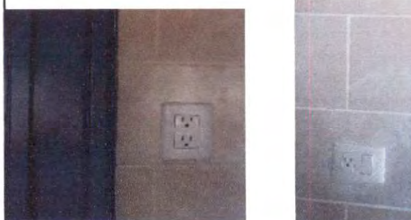
Foto 24: Reparación en el sistema eléctrico.
