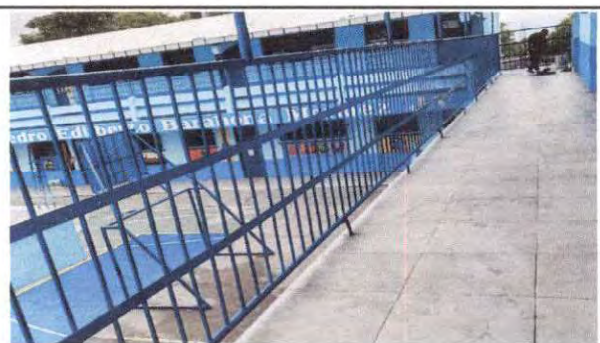
Foto 18: Reforzar barandal del segundo nivel, no es estable, es peligro para los alumnos.
