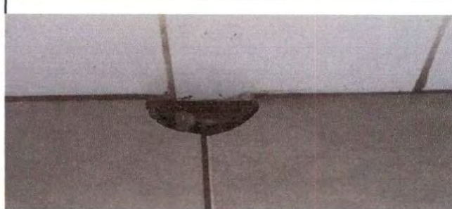
Foto 14: Destapar drenajes en área de baños.
