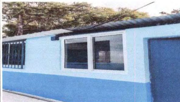
Foto 2: Se colocaron las ventanas correspondientes.
