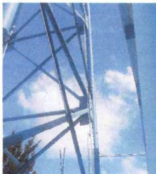
Foto 13: Cambio de toda la instalación y reparación del tinaco.
