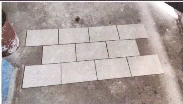
Foto 1: Sellar reposadera que causa inundación dentro de la cocina.
