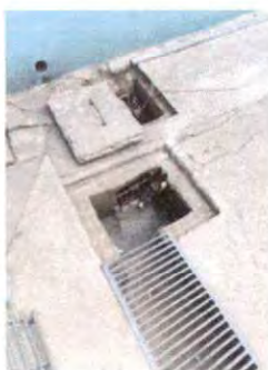
Foto 21: Mantenimiento de drenajes.
