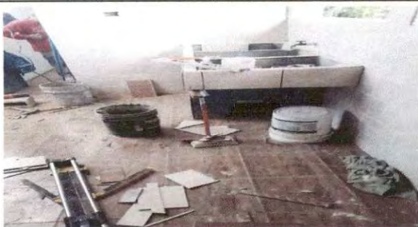
Foto 5: Colocar piso cerámico como prevención al deterioro de la fundición.
