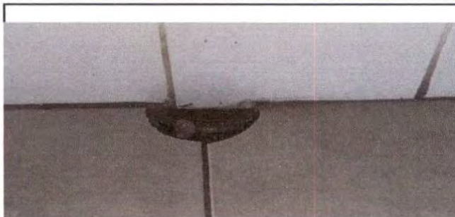
Foto 14: Destapar drenajes en área de baños.
