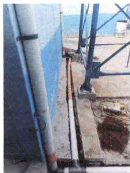
Foto 15: Reparación e instalación nueva ya que hay constante fuga el tinaco principal de agua.
