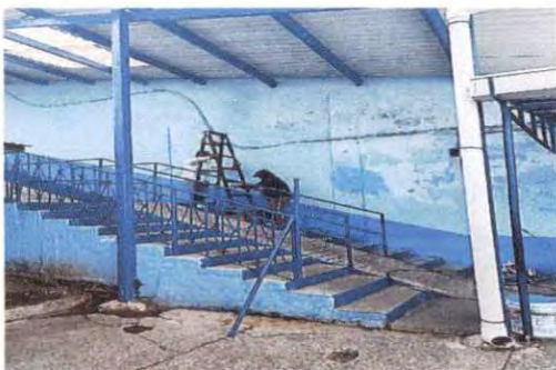
Foto 19: Aplicación de pintura en muro perimetral de ingreso.
