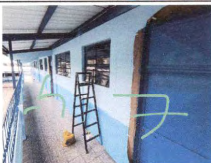
Foto 23: Pintura en puertas.
