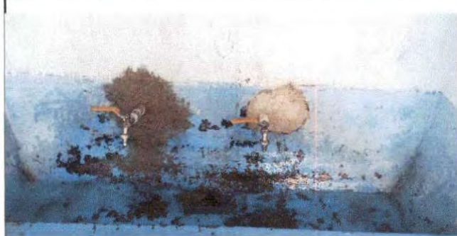
Foto 16: Pintura en área de lavamanos y pila.
