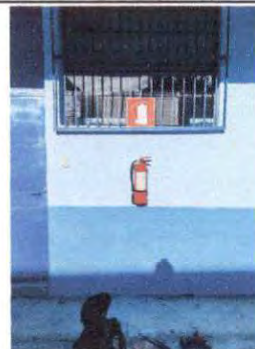
Foto 22: Aplicación de pintura.
