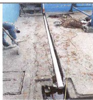
Foto 12: Modificar las bajadas de agua para evitar mantener el área húmeda y resbalosa.
