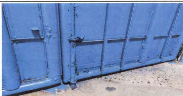
Foto 17: Pintura y lijado de portón de ingreso principal.
