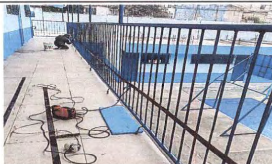
Foto 18: Reforzar barandal del segundo nivel, no es estable, es peligro para los alumnos.
