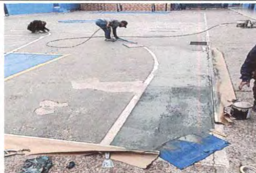
Foto 20: Aplicación de pintura en cancha y marcaje.
