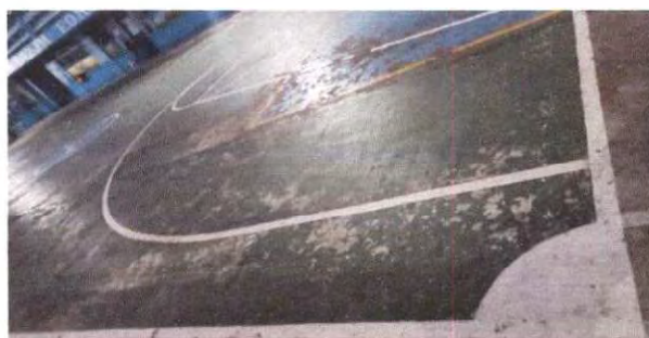
Foto 20: Aplicación de pintura en cancha y marcaje.
