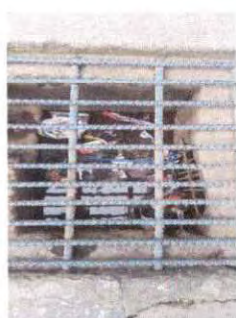
Foto 21: Mantenimiento de drenajes.
