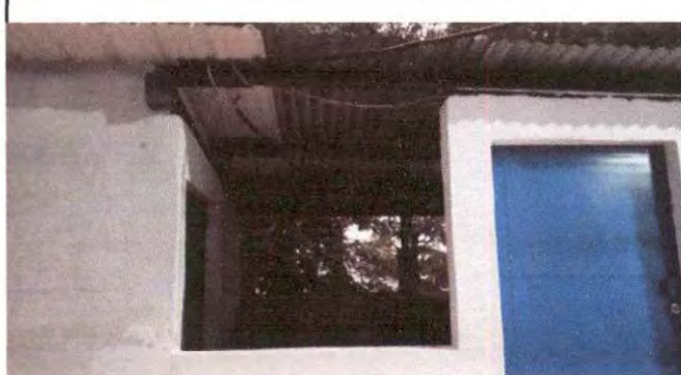
Foto 2: Se necesita colocar ventana en la cocina en la parte frontal con su respectivo balcón para más seguridad.
