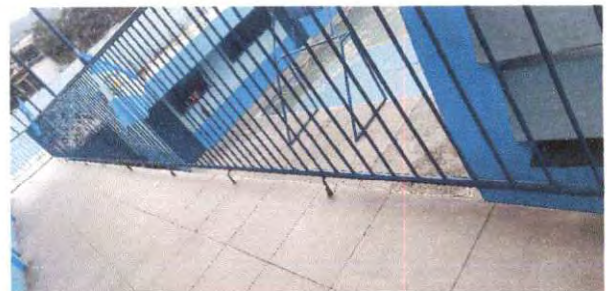
Foto 18: Reforzar barandal del segundo nivel, no es estable, es peligro para los alumnos.
