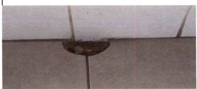
Foto 14: Destapar drenajes en área de baños.
