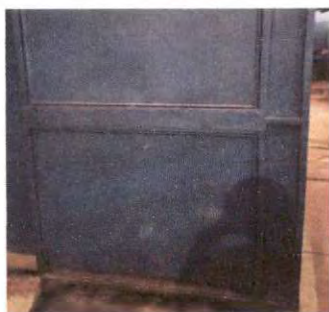
Foto 23: Pintura en puertas.
