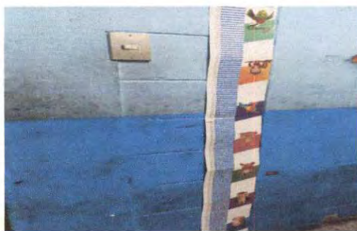
Foto 22: Aplicación de pintura.
