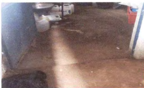
Foto 5: Colocar piso cerámico como prevención al deterioro de la fundición.
