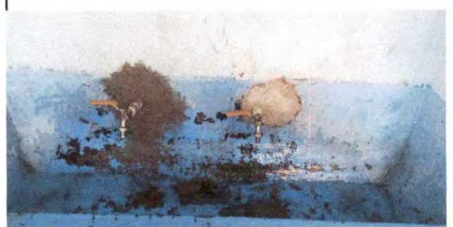
Foto 16: Pintura en área de lavamanos y pila.
