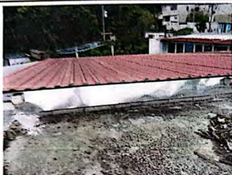
Foto 1: Colocación de Flashing para evitar problemas de filtración.
