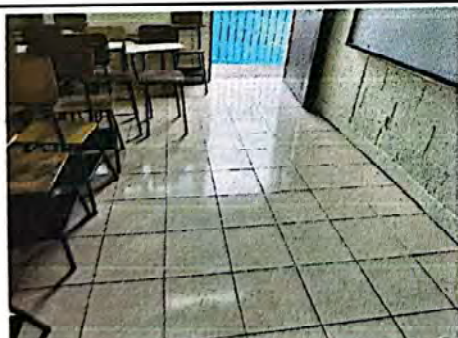
Foto 5: Suministro e instalación de piso cerámico.
