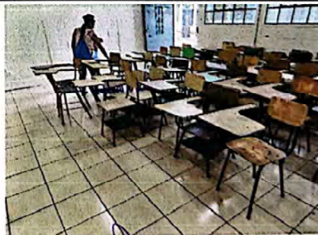
Foto 6: Suministro e instalación de piso cerámico.
