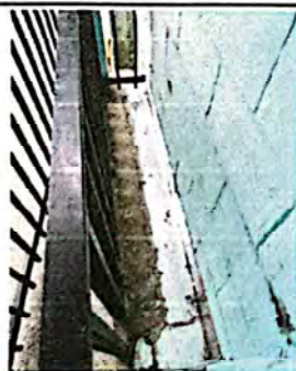
Foto 9: Colocación de Flashing para generar el sello en la junta de dilatación del módulo de gradas y el módulo de aulas, para evitar problemas de humedad.
