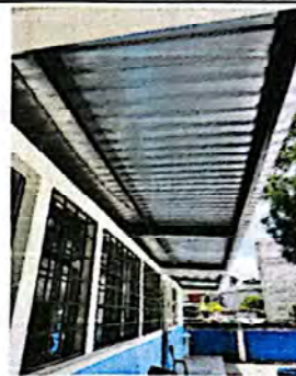
Foto 8: Instalación de láminas troqueladas nuevas.
