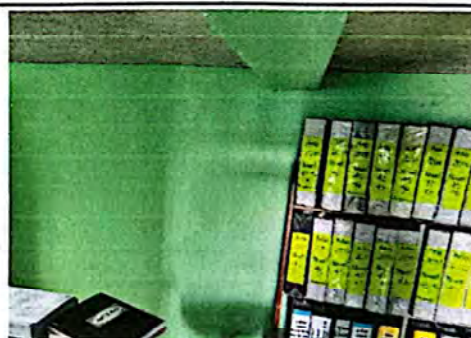
Foto 10: Aplicación de pintura en área de oficina que presentaba problemas de humedad por la filtración en junta de dilatación.
