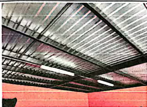
Foto 7: Se puede apreciar el mantenimiento a la estructura de soporte y la colocación de las láminas nuevas.
