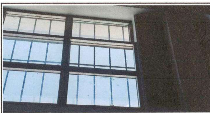
Imagen de ventanas con vidrios nuevos en modulos 3 y 4
