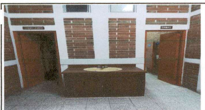
Imagen de area de instalaciòn de lavamanos en area administrativa
