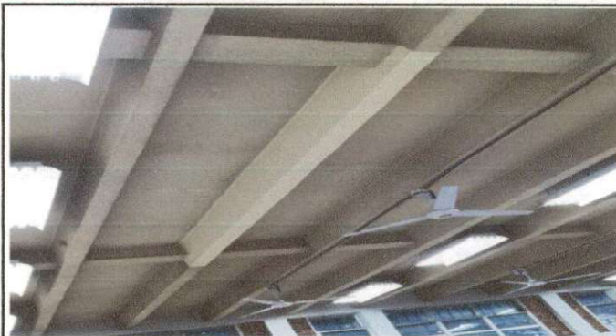
Imagen del cambio de vidrios quebrados diferentes modulos
