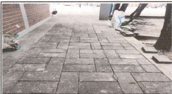
Imágenes de reparacion de fuga en muro de banos administracion
