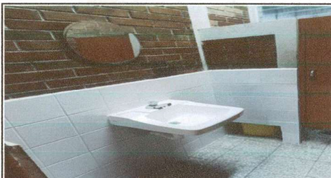
Imágenes de reparacion de baño de mujeres area administrativa
