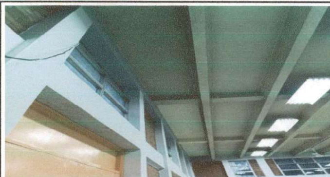
Imagen de finalizacion de remosamiento de viga en SUM
