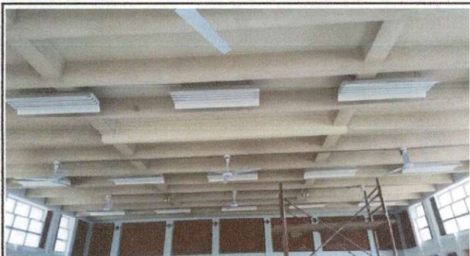
Imagen de reparacion de vigas internas del SUM al ingreso del modulo
