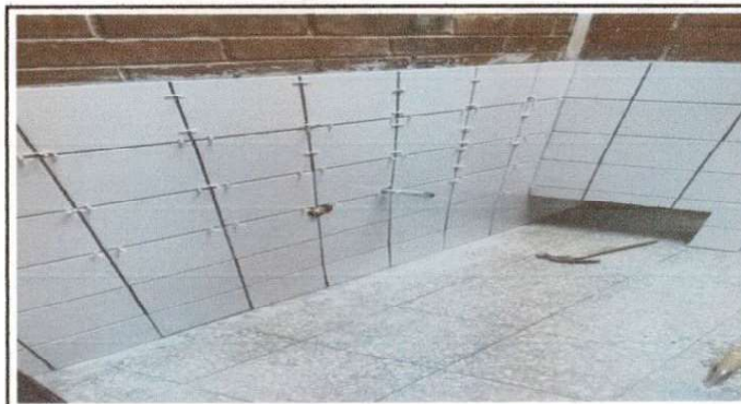
Imagen de colocacion de azulejo en reparacion de fuga banos
