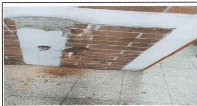
Imagen de reparacion y puesta de tuberia para lavamanos administracion
