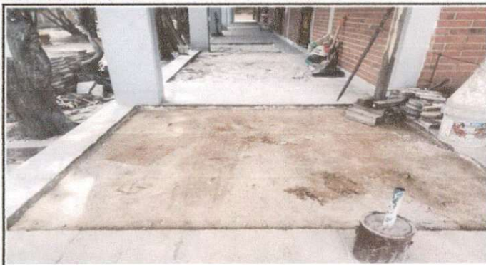
Reparacion de losa de piso en pasillos de modulos
