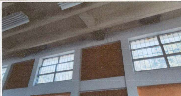
Imagen de reparacion de vigas internas del SUM al ingreso del modulo
