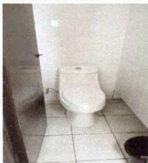
Foto1: Final sanitarios alumnas
