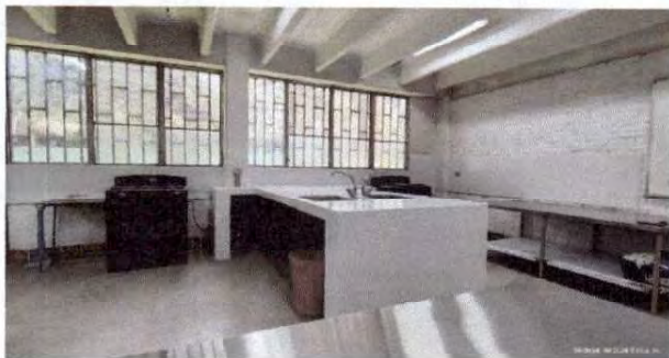
Foto 1: Final instalación de azulejo y grifería en isla del taller de cocina.
