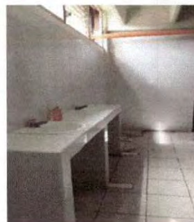
Foto 2: final sanitarios alumnas
