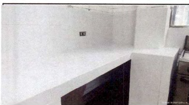
Foto 4: final de instalación de azulejo en paredes del taller de cocina.
