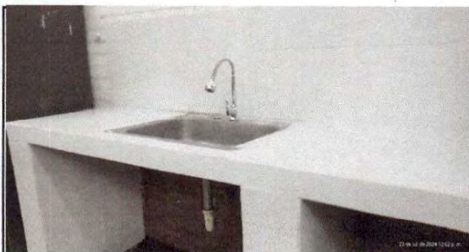
Foto 3: Final instalación de azulejo, grifería y agua potable a iisla pequeña del taller de cocina
