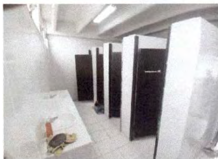
Foto 3: Final sanitarios alumnas
