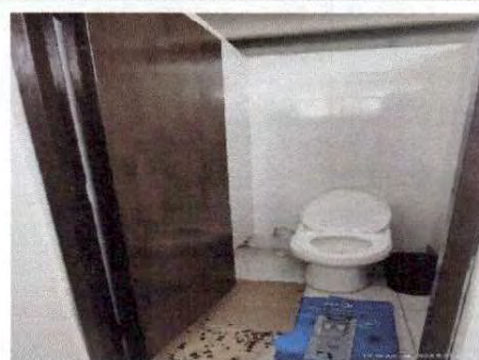
foto 6 pintura de puertas.
