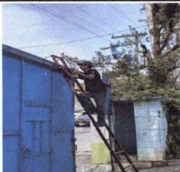
Foto1: Reparación de puente de portón
