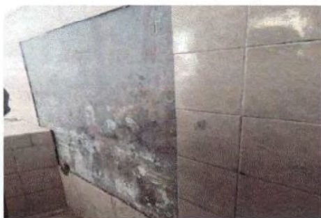
Foto1 desmontaje de azulejo antiguo.
