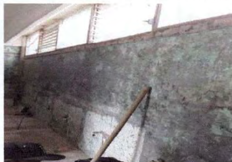
Foto 2: Edesmontaje de todo el azulejo de las paredes.
