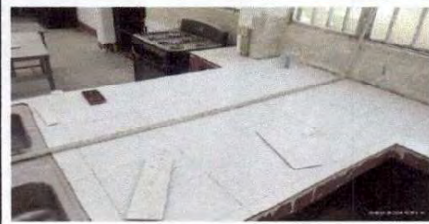
Foto 2: Colocación de azulejo en isla mayor
