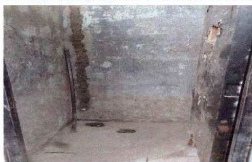
Foto 4. conexión de acometida de agua.
