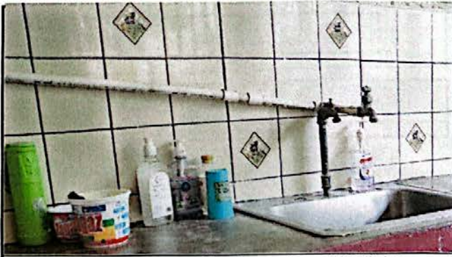
Foto 6: Acometidas de agua potable sobrepuestas, mal instaladas.
