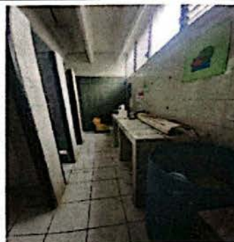
Foto 4: Los lavamanos estan tapados en el sistema de drenajes, necesita la reubicación para colocar 3 urinales para varones.
