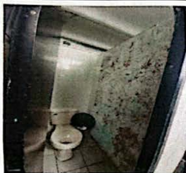
Foto 3: El azulejo de las paredes se cayó y la acometida de agua potable se taó por sarro, falata pintura y sistema de iluminación eléctrica.
