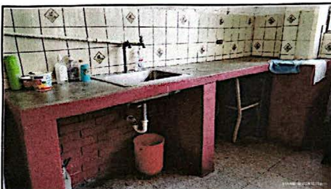
Foto 4: Esta fotografía corresponde a la segunda isla, es de menor dimensión, por igual necesita ser cubierta de azulejo blanco para evitar la proliferación de bacterias y sea de fácil limpieza.
