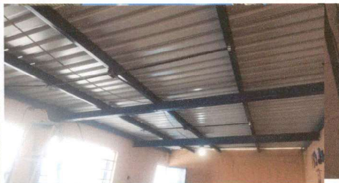
Foto 1. Así queda el trabajo del techo del salón C.
