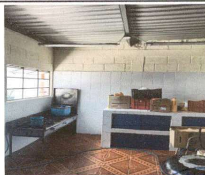
Foto 6. Proceso de trabajo de colocación de cerámica en la cocina.
