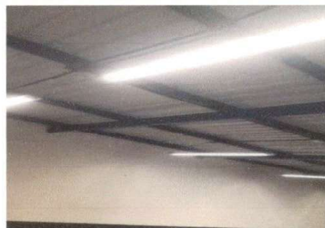
Foto 2. Aquí se evidencia el trabajo finalizado del salón C con su sistema de alumbrado.
