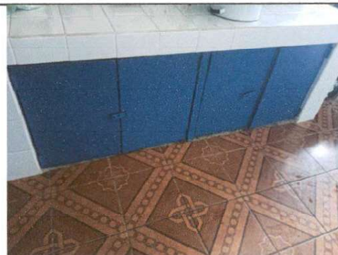
Foto 4. Mesón remodelado y terminado.
