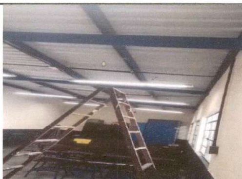
Foto 3. Proceso de finalización del salón C con su nueva estructura de techo con nuevo sistema eléctrico.
