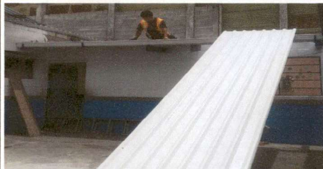
Foto 2. Proceso de colocación de nueva lámina al techo del salón C
