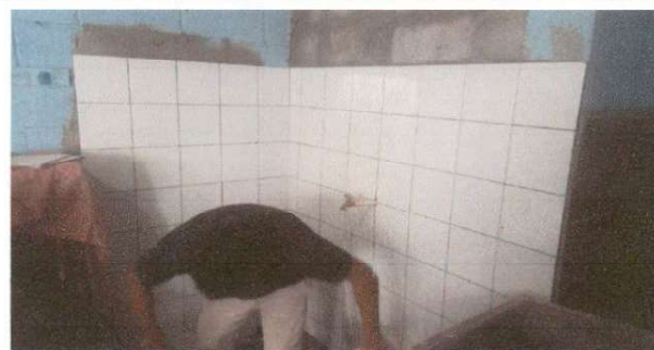
Foto 6. Proceso de trabajo de colocación de cerámica en la cocina.
