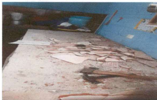
Foto 4. Instalación de cerámica de mesón de la cocina.
