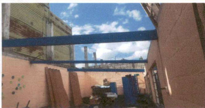
Foto 1. Proceso de desmontado de lámina y pintado de costaneras para cambio de techa de aula C.
