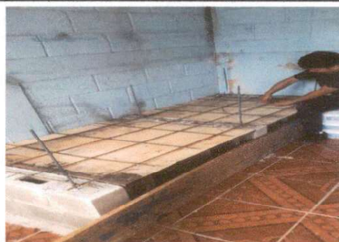
Foto 5. Colocación y finalización de cerámica en el fondo de la cocina, también colocación de tomacorrientes.
