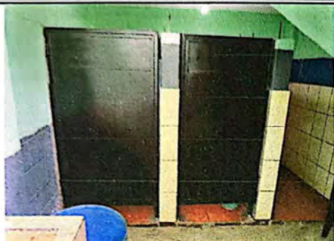
Foto 1: Mantenimiento a puertas de baños de niños, incluye el lijado y la pintura.
