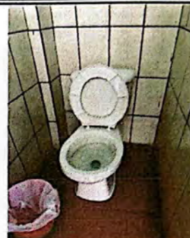
Foto 2: Inodoros nuevos, debidamente instalados.
