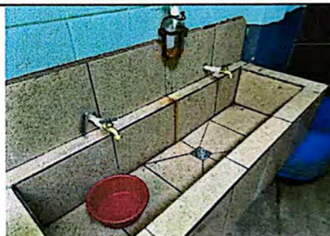
Foto 4: Suministro e instalación de chorros en pilatas.
