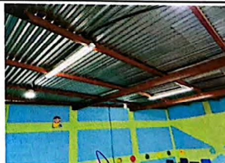
Foto 6: Suministro e instalación de Lámparas en salón de clases.
