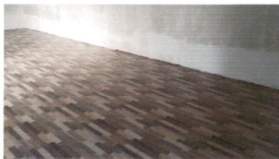
Foto 2: INSTALACION DE PISO EN LABORATORIO DE COMPUTO
