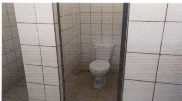
Foto 3: CAMBIO DE SANITARIO
