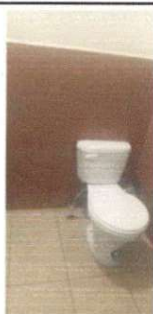
Foto 5: instalacion de piso ceramico
