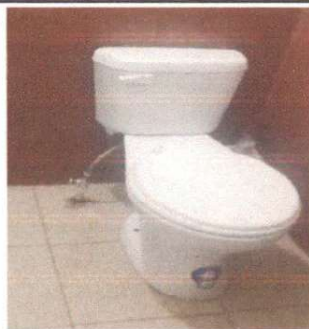
Foto 3: CAMBIO DE SANITARIO
