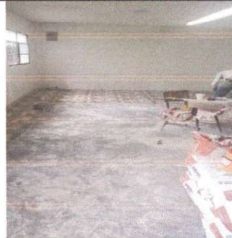
Foto 2: INSTALACION DE PISO EN LABORATORIO DE COMPUTO
