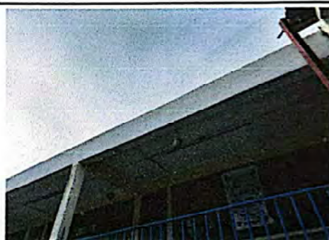
Foto 4: Trabajos de resanado de vigas en interior.
