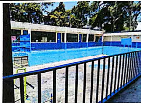
Foto 2: Trabajos de mantenimiento a barandilla.
