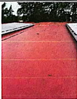
Foto 5: Aplicación de Impermeabilizante en losa.
