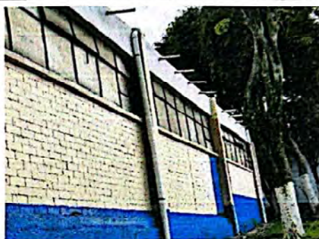
Foto 8: Aplicación de monocapa blanco para acabado en vigas exteriores.
