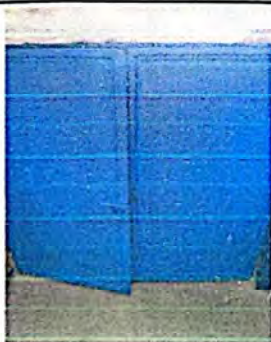
Foto 9: Mantenimiento a Puertas para la bodega de la bomba.
