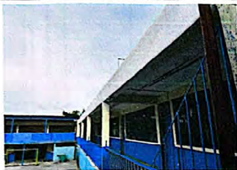
Foto 7: Aplicación de monocapa blanco para acabado en vigas interiores.
