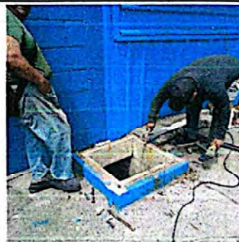
Foto 10: Mantenimiento a Puertas de cisterna.
