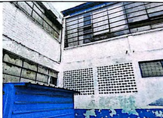
Foto 10: La pintura se encuentra deteriorada por el paso del tiempo, afectando el aspecto visual del establecimiento.
