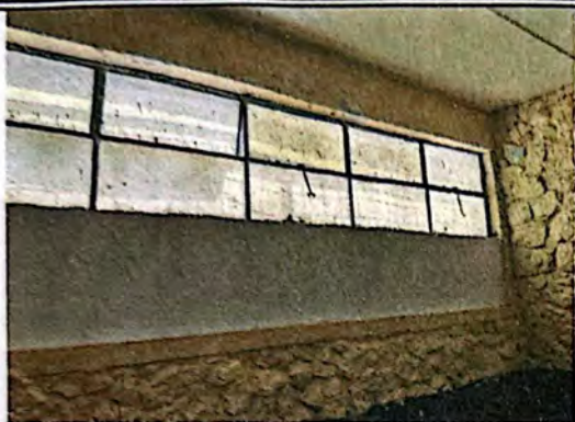
Foto 7: Debido al estilo de ventana que se tiene que no permite la apertura de una buena sección para la ventilación se acumula el calor.
