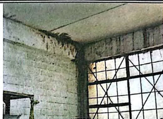
Foto 2: Se aprecian los problemas de filtración dentro de las aulas, el cuál se agrava en época de lluvia.
