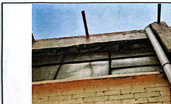
Foto 5: Debido a la humedad el perímetro del edificio, presenta problemas de desprendimiento de la capa de concreto que reviste las varillas de acero corrugado.
