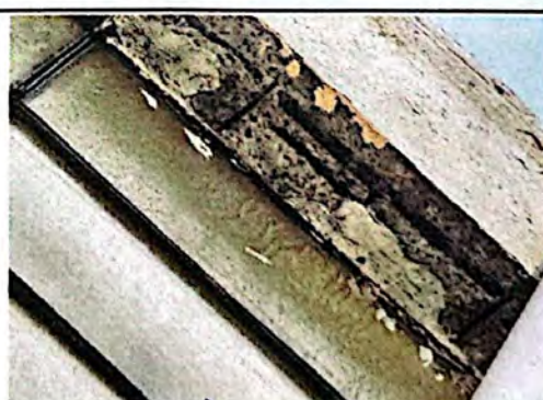
Foto 6: En algunos puntos del edificio la armadura de acero se encuentra expuesta, lo que la hace mas vulnerable a la corrosión.
