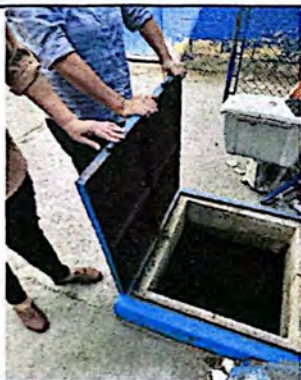
Foto 9: La puerta tipo escotilla con la que cuenta el cisterna está fuertemente afectada por el óxido, por lo que deberá ser sustituida.
