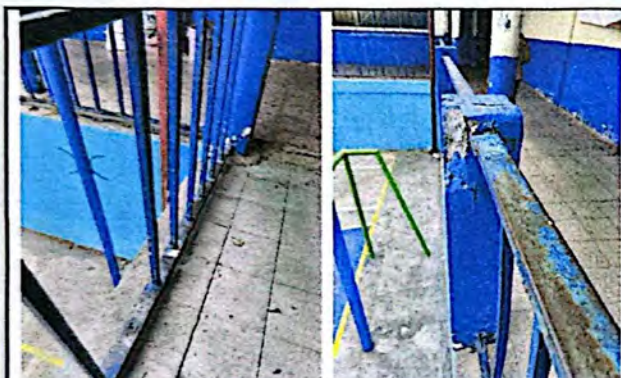
Foto 3: Mantenimiento a barandilla de pasillos en el edificio del establecimiento, incluye lijado, pintura y colocación de piezas faltantes.
