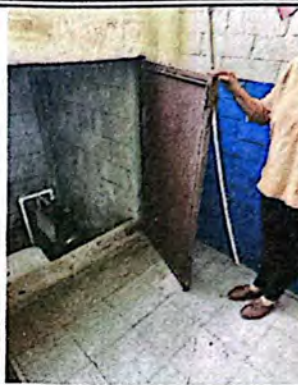
Foto 8: La puerta que resguarda el sistema de bombeo, tiene una fuerte cantidad de óxido, por lo que deberá ser reemplazada.
