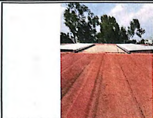
Foto 1: En puntos en específico la membrana impermeabilizante se encuentra suelta debido a esto es que se tienen problemas de filtración en la parte interna.
