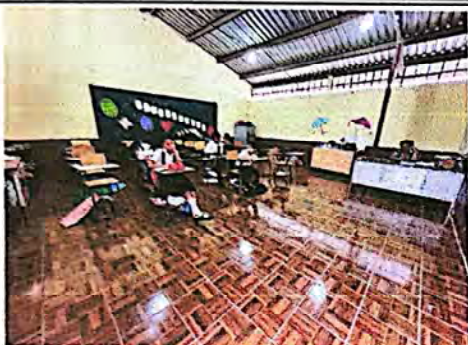
Foto 7: Suministro e instalación de piso cerámico.
