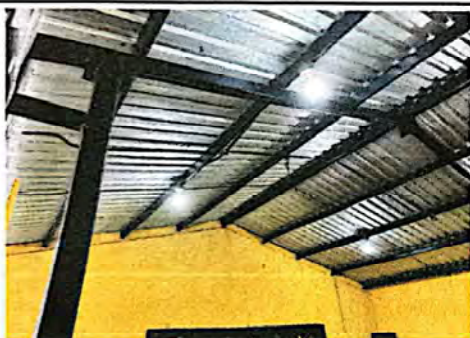
Foto 3: Mantenimiento a la estructura de techo + instalación de lámina troquelada
