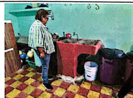
Foto 6: Suministro e instalación de pila en cocina.
