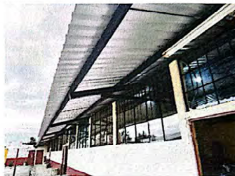
Foto 2: Se realizó el mantenimiento a la estructura de techo y marcos de ventanas incluyendo lijado y pintura + colocación de vidrios.
