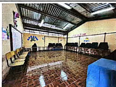
Foto 8: Se instaló piso cerámico en el salón de computación.
