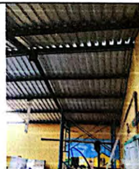
Foto 6: Montaje de lámina troquelada nueva en salón de clases.
