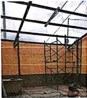
Foto 1: Se desmontan las láminas en mal estado.
