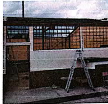
Foto 2: Salón de clases sin techo, listo para recibir el mantenimiento a la estructura de soporte.
