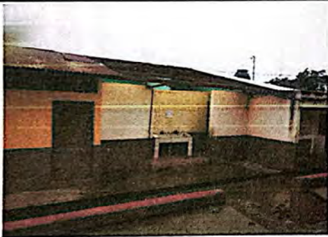
Foto 3: Se desmonta el techo en el área de baños.
