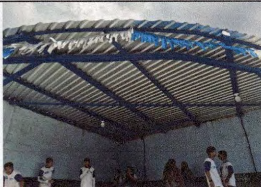
Foto1: Cambio de techo
