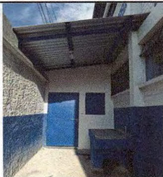
Foto 5: Techo de de pila, luz, nivelación de suelo y luz.
