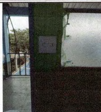
Foto 2: Colocación de apagadores nuevos en aulas
