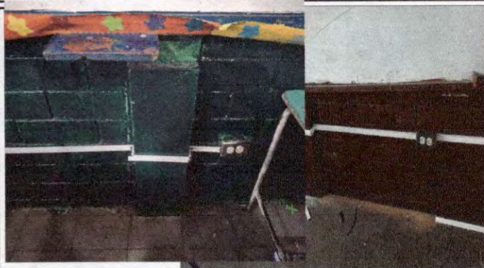
Foto1: Instalación de tomacorrientes en aulas
