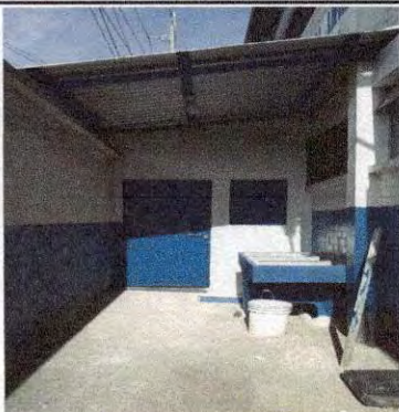
Foto 3: Colocacion de puerta y ventana de metal.
