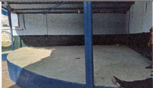
Foto 3: Cernido y Pintura en suelo.
