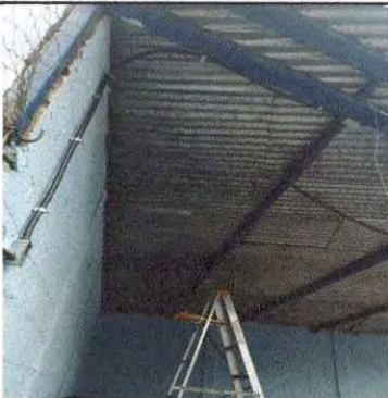
Foto 5: Colocación de tomacorrientes en escenario.
