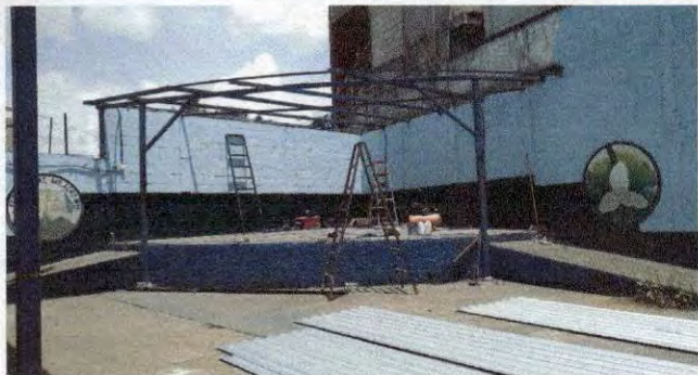
Foto1: Sustitución de lamina en mal estado por nueva
