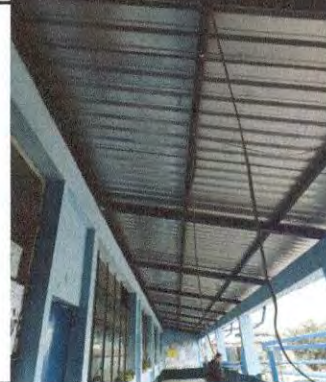
Foto 2: Instalación de cableado en pasillos de segundo nivel.
