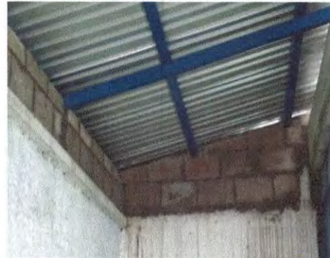
Foto 2: Hilladas de block para mejorar la altura.
