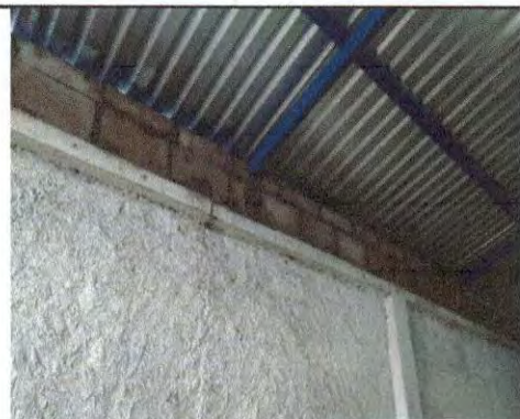
Foto 4: Hilladas de block para mejorar altura.
