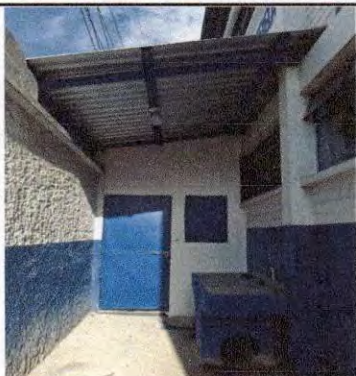
Foto 3: Colocacion de lamina sobre espacio de pila.
