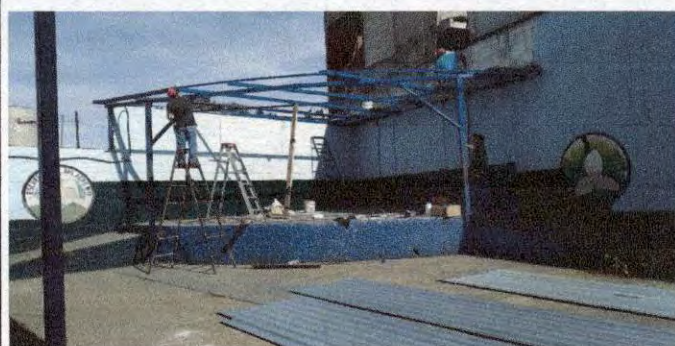
Foto 2: Mantenimiento a estructura de metal y pintura.
