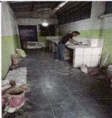
Foto1: colocacion de piso y azulejo en plancha de cocina
