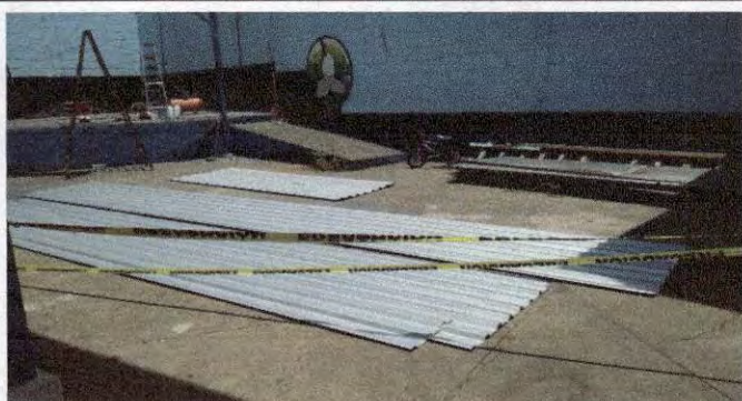
Foto 3: Instalación de nueva lamina.
