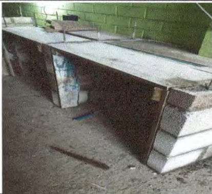
Foto 3:Construcción de plancha de block
