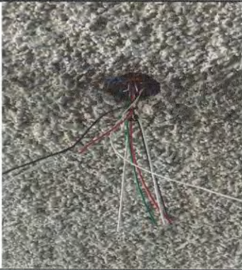
Foto 1: Instalación de cableado en aulas
