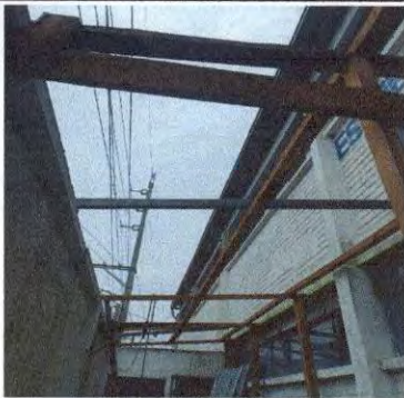
Foto 5: Se elimina lamina en mal estado.
