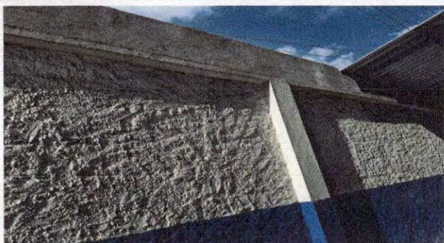
Foto 5: Colocacion de 2 hiladas de Block en orilla de calle para mejorar la seguridad.
