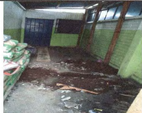
Foto 4: Escabación para implementación de drenaje.
