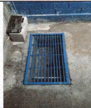
Foto 4: colocacion de regilla en drenaje .
