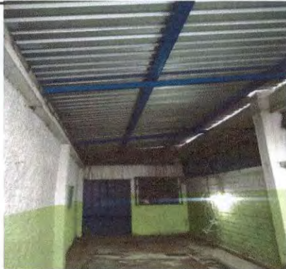
Foto 3: Colocación de lamina
