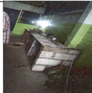
Foto 4: Fundición de plancha de Block en cocina.
