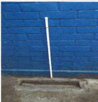
Foto 5: Implementación de tubería para agua potable.
