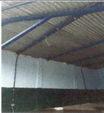
Foto 3: Instalación de cableado en escenario, focos y tomacorrientes.
