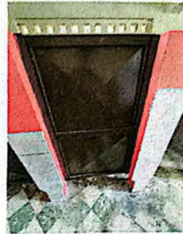
Foto 2: Mantenimiento a puertas metálicas, incluye lijado y pintura.
