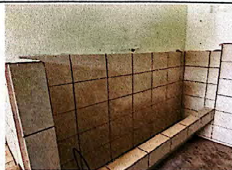
Foto 6: Suministro e instalación de azulejo el mijitorio.
