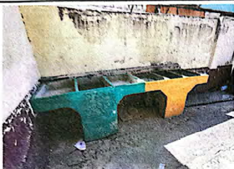
Foto 7: Suministro e instalación de pilas.
