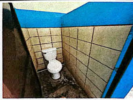
Foto 4: Instalación de azulejo en baños.
