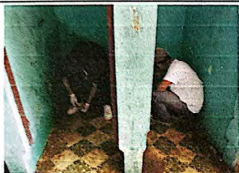
Foto 1: Se desmontan los inodoros en mal estado y se limpia el área.
