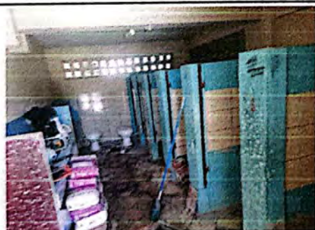
Foto 5: Se utilizará PSP para el pegado del azulejo el cuál permite una buena adherencia de los azulejos en los muros.
