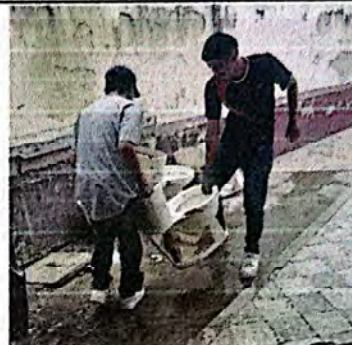
Foto 2: Retiro de inodoros que serán desechados y sustituidos.
