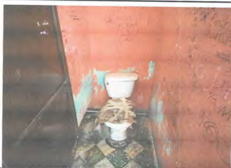
Foto 3: Baños Niñas, en mal estado es necesario sustituir sanitario y colocar azulejo y aplicación de pintura en muros
