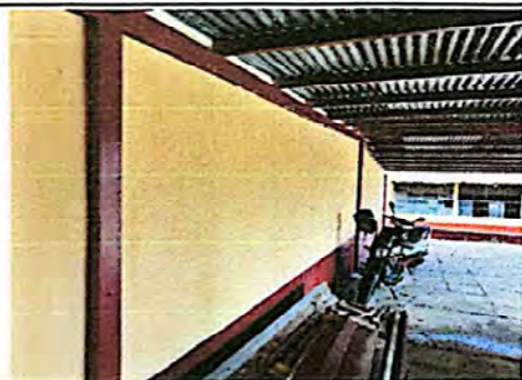
Foto 9: Se aplicó repello y pintura para el acabado final.
