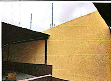
Foto 7: Muro perimetral de mampostería reforzada.
