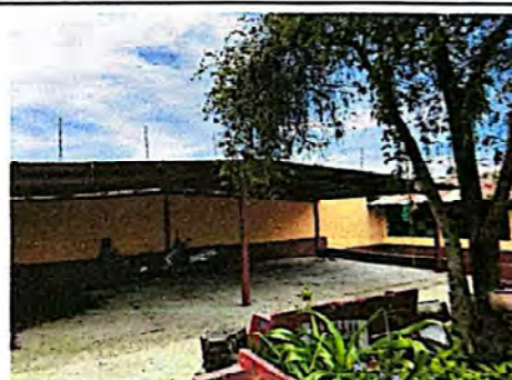
Foto 10: Vista general del muro.
