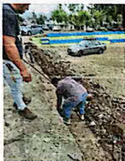
Foto 1: Excavación para cimentación de muro.
