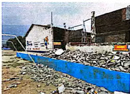
Foto 3: Demolición y retiro de escombros
