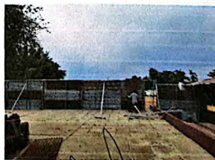
Foto 6: Muro de protección con temporal con lámina.
