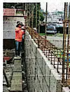
Foto 4: Levantado de muro, armado de columnas y soleras.
