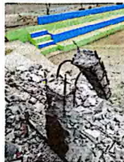
Foto 2: Demolición de muro existente
