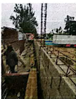
Foto 5: Preparación de Formaleta para fundición de solera
