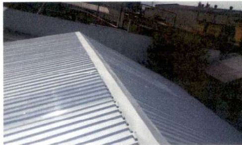
Foto 2: Techo aulas: se cambio el techo de duralita por láminas, en dos aulas.
