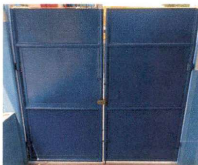
Foto 6: Portón: Reparación y pintura del portón
