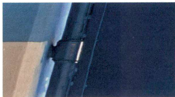
Foto 2: Portón: Se aseguro Bisagra, se lijo y pinto
