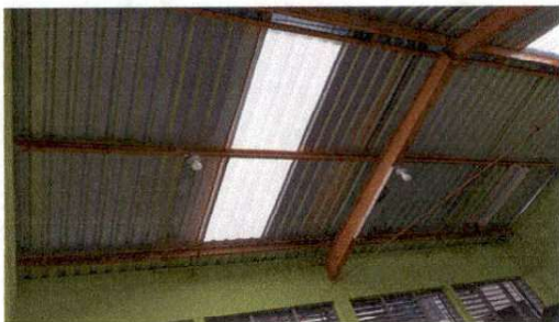
Foto 1: Techo de aulas: se cambio la duralita por lámina, en dos aulas, se colocaron dos laminas transparentes, para una mayor iluminación.
