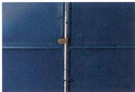
Foto 1: Área de potones: puerta pequeña se pinta y repara
