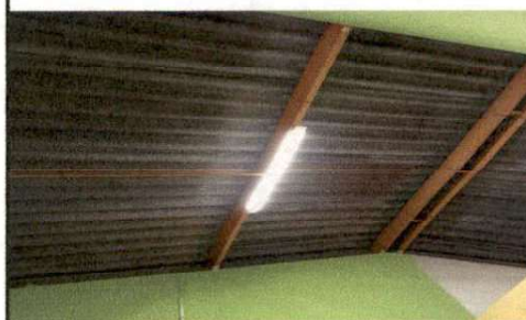
Foto 4: Sistema eléctrico: Quitar los materiales sin funcionalidad
