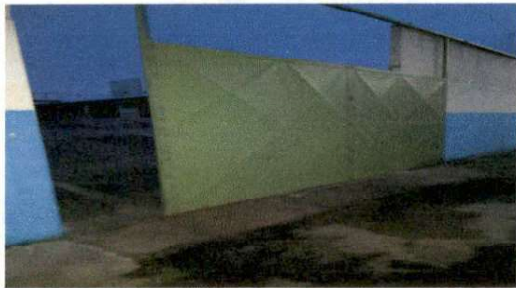
Foto 3: Cambio del portón grande, se realiza corredizo, para un facil acceso
