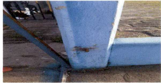
Foto 4: El portón grande se a removido de su base
