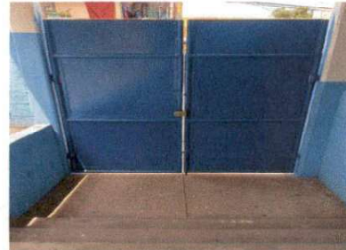
Foto 6: Portón pequeño se le cambio partes de la lámina y nueva pintura
