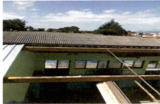
Foto 2: Módulo de aulas, El techo sera de lámina
