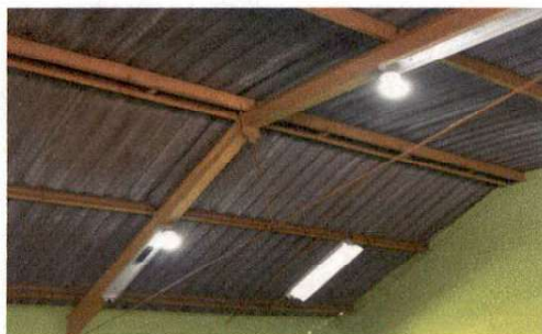
Foto 5: Sistema eléctrico: Se reemplaza cableado
