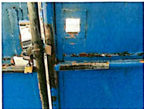
Foto 3: ÁREA DE PORTONES, PORTÓN PEQUEÑO, EL ÓXIDO IMPIDE QUE SE SE ABRA CON FACILIDAD.
