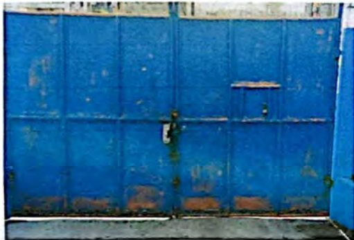
Foto 3: ÁREA DE PORTONES, PORTÓN GRANDE DIFÍCIL ACCESO; YA QUE SE TRABA EL MECANISMO PARA ABRIRLO.
