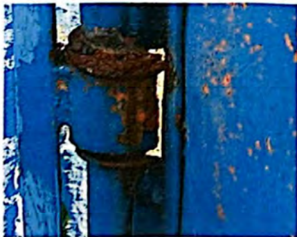
Foto 5: ÁREA DE PORTONES, PORTÓN GRANDE TIENE ÓXIDO EN LA BISAGRAS.
