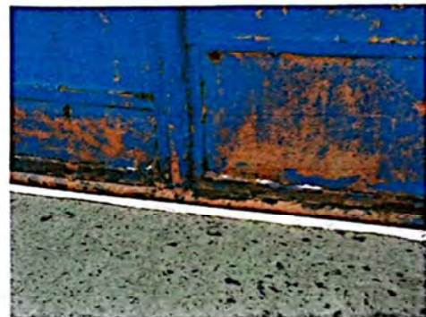
Foto 4: ÁREA DE PORTONES, PORTÓN GRANDE EL ÓXIDO LO ESTÁ DETERIORANDO DE ABAJO.
