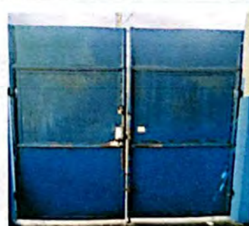
Foto 6: ÁREA DE PORTONES, PORTÓN PEQUEÑO, SE DETERIORA POCO A POCO A CAUSA DEL ÓXIDO.
