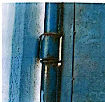
Foto 2: ÁREA DE PORTONES, PORTÓN PEQUEÑO, EL ÓXIDO INICIA EN LA BISAGRAS Y OTRAS PARTES DEL PORTÓN.
