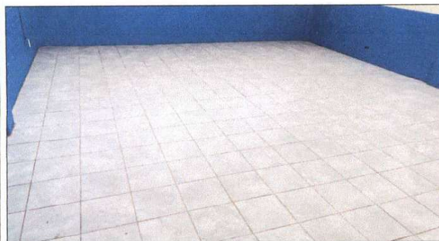
Foto 3: Finalización de piso nuevo de la bodega de la Cocina Escuela Dario González
