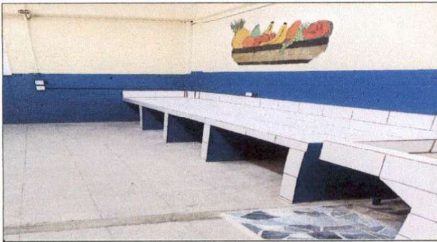
Foto1: Paredes pintadas de la Cocina Escuela Dario González
