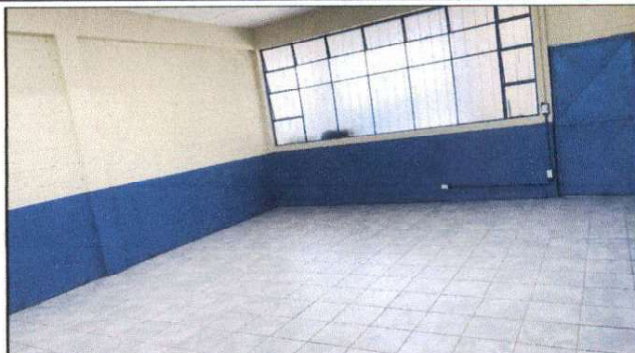
Foto 2: Ventanal puerta pintada.
