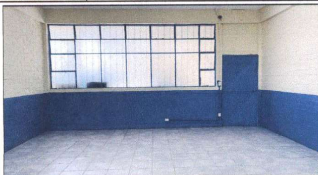
Foto1: Paredes pintadas de la bodega de la Cocina Escuela Dario González
