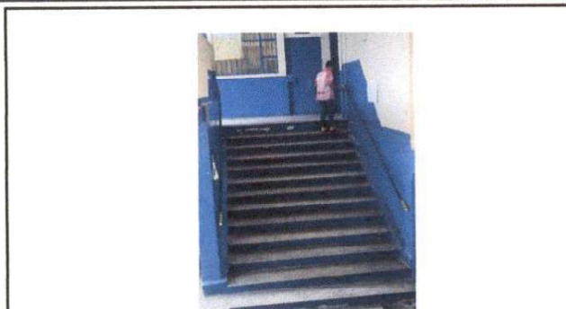
Foto 2: Instalación de pasamanos de los pasillos de la Escuela Dario González
