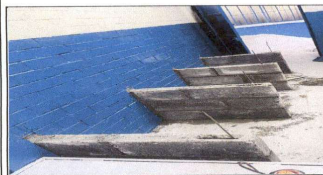
Foto 5: Construcción de nueva mesa de concreto de la cocina de la Escuela Dario González
