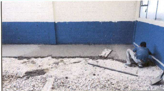
Foto 2: Preparación de base para instalación de piso nuevo de la bodega de la cocina de la Escuela Dario González
