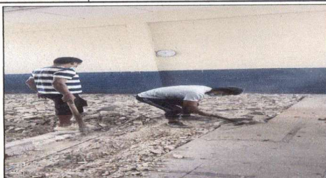
Foto 1: Destrucción del piso antiguo que se encontraba en muy mal estado en la bodega de la cocina de la Escuela Dario González
