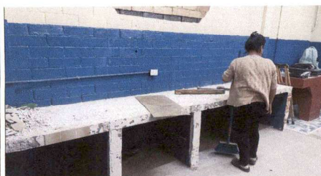
Foto 3: Destrucción del azulejo antiguo que se encontraba en muy mal estado de la mesa de concreto de la cocina de la Escuela Dario González
