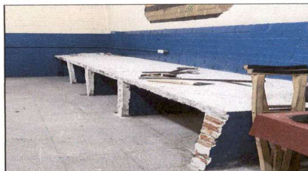
Foto 4: Reforzamiento de la mesa de concreto de la cocina de la Escuela Dario González
