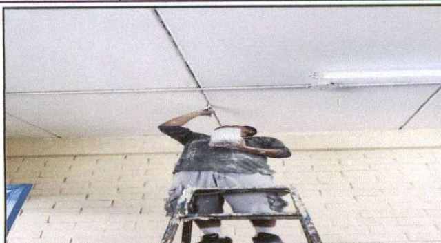
Foto1: Resanamiento y pintura de los techos de la cocina y bodega de la Escuela Dario González
