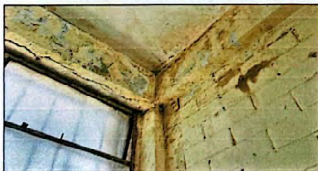
Foto 5: Reparación de 1 Viga en mal estado
