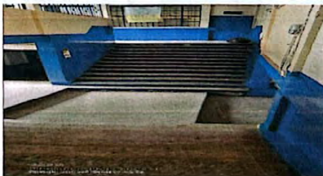
Foto 6: Pasillo para poner 4 de 2mts L pasamanos
