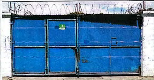
Foto 1: Reparación de portón principal (convertirlo en corredizo)
