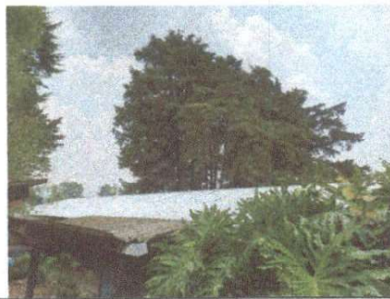
Foto 6: Colocación de laminas para aulas.
