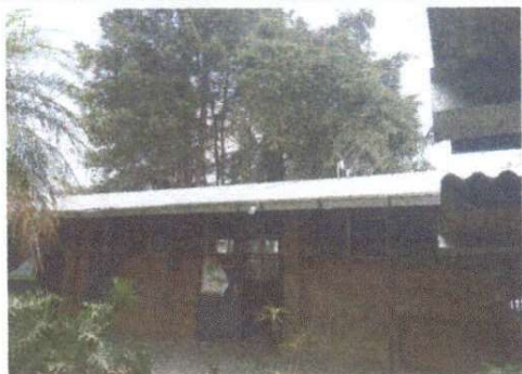
Foto 1: Colocación de laminas para aulas.
