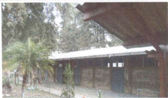
Foto 3: Colocación de laminas para aulas.
