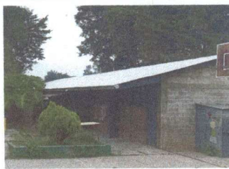
Foto 2: Colocación de laminas para aulas.
