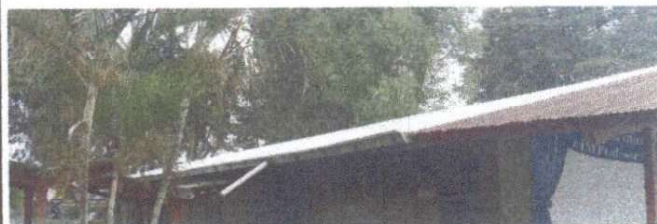
Foto 4: Colocación de laminas para aulas.
