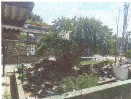
Foto 3: Limpieza de áreas.
