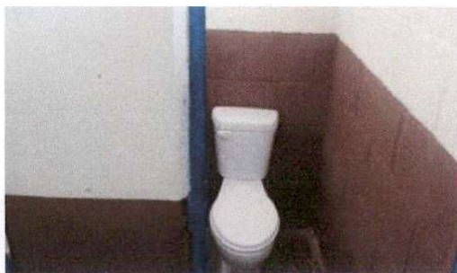
Foto 7: Montaje de sanitarios
