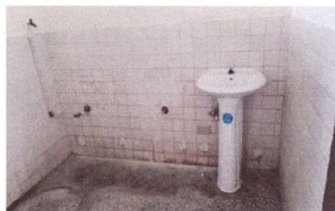
Foto 8: Montaje de Lavamanos
