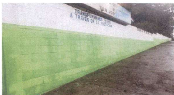
Foto 9: Pintura exterior EOUM No. 459 San Jose las Rosas
