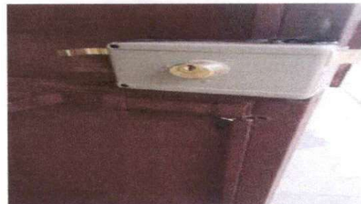
Foto 2: Colocacion de Chapas Yale
