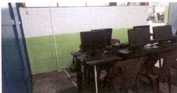
Foto 3: Remozamiento Instalacion electrica Laboratorio de Computo
