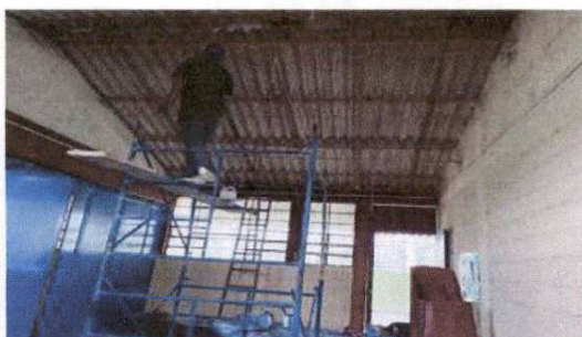
Foto 9: Remozamiento Instalacion electrica Laboratorio de Computo
