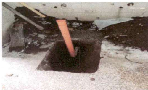
Foto 1 Desmontaje y montaje de 14 sanitarios Módulo 1
