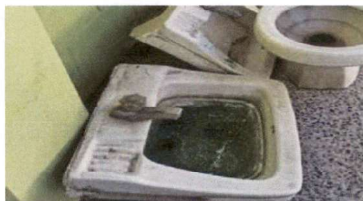
Foto 6: Desmontaje y montaje de 4 lavamanos Modulo 3, en cada baño hay 3 lavamanos, se quitaran y solo se colocara 1 por baño es por eso que se colocaran 4 lavamanos por modulo
