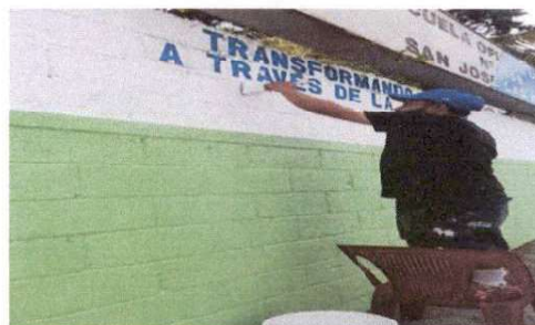
Foto 8: Pintura Exterior de la EOUM No. 459 San Jose las Rosas (100 metros)
