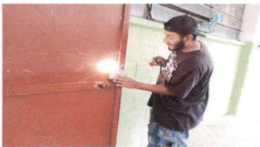
Foto 7: Colocación de 10 chapas marca yale
