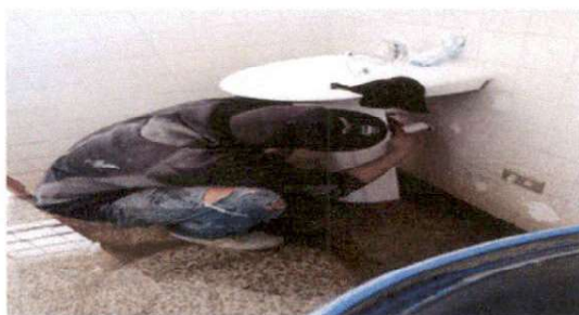
Foto 5: Montaje de lavamanos en los tres módulos
