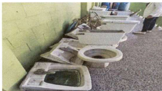
Foto 2: Desmontaje y montaje de 14 Sanitarios Módulo 2
