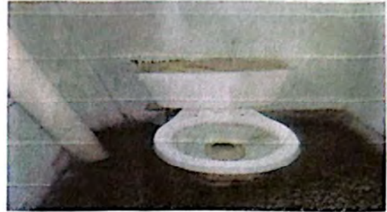
Foto 2: Desmontaje y montaje de 14 Sanitarios Módulo 2
