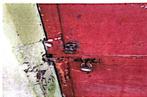
Foto 10: Desmontaje y montaje de 3 chapas marca Yale en 3 puertas de aulas del Modulo 2
