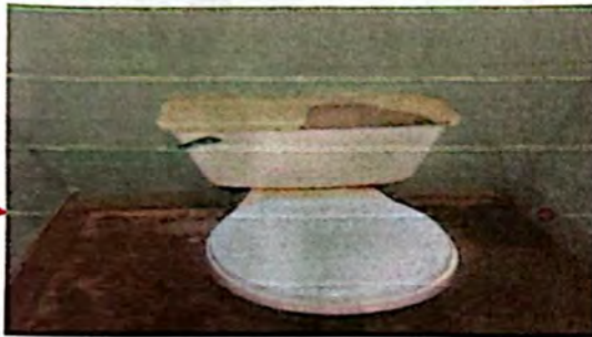
Foto 3: Desmontaje y Montaje de 14 Sanitarios Módulo 3
