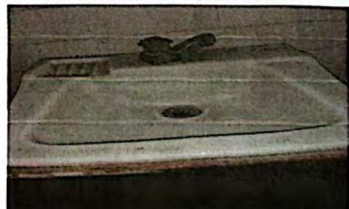
Foto 6: Desmontaje y montaje de 4 lavamanos Modulo 3, en cada baño hay 3 lavamanos, se quitaran y solo se colocara 1 por baño es por eso que se colocaran 4 lavamanos por modulo
