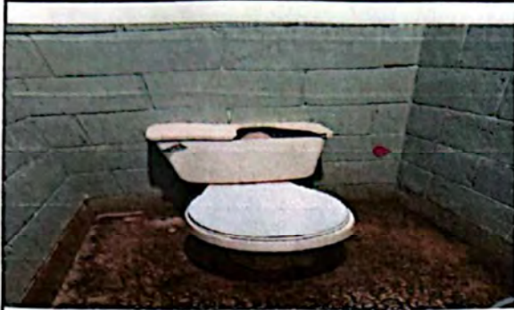
Foto 1 Desmontaje y montaje de 14 sanitarios Módulo 1
