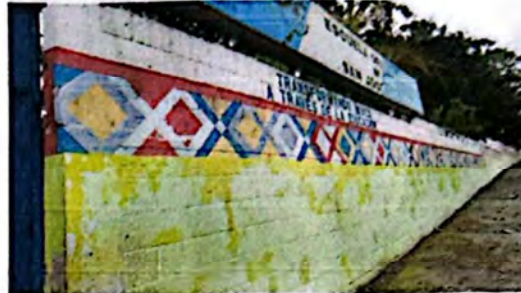
Foto 8: Pintura Exterior de la EOUM No. 459 San Jose las Rosas (100 metros)
