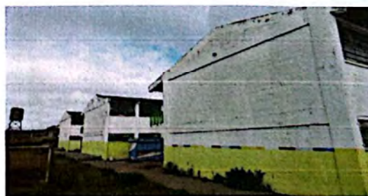
Foto 12: Pintura Interior en las paredes del tope de cada modulo (3 modulos)
