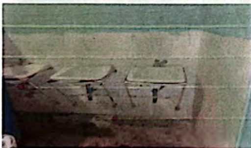
Foto 5: Desmontaje y montaje de 4 lavamanos Modulo 2, en cada baño hay 3 lavamanos se quitaran y solo se colocara 1 por baño es por eso que se colocaran 4 lavamanos por modulo
