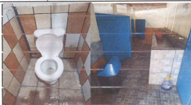
cambio de baño y piso
