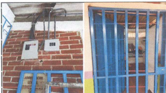
cambio de caja y puerta de reja
