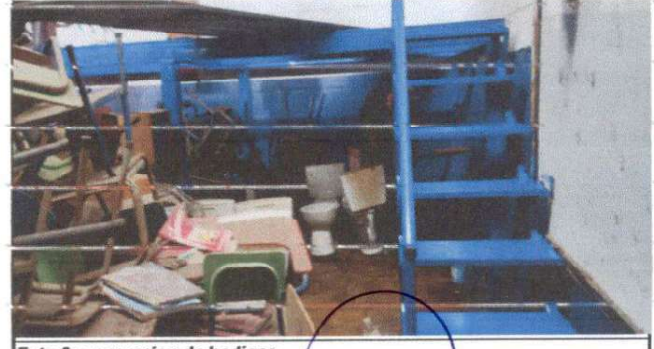
Foto 6: reparación de bodegas
