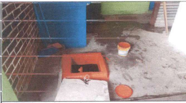
Foto 5: limpieza de sistema y pintura
