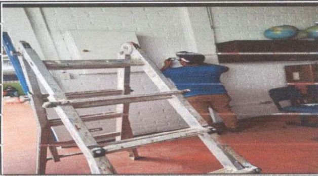
Foto 1: Reparación de Dirección
