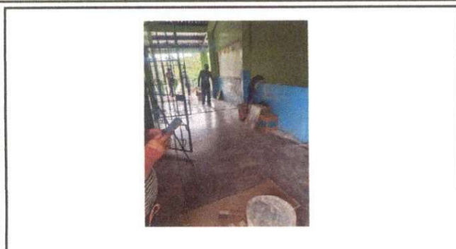
corredor del 2do nivel
