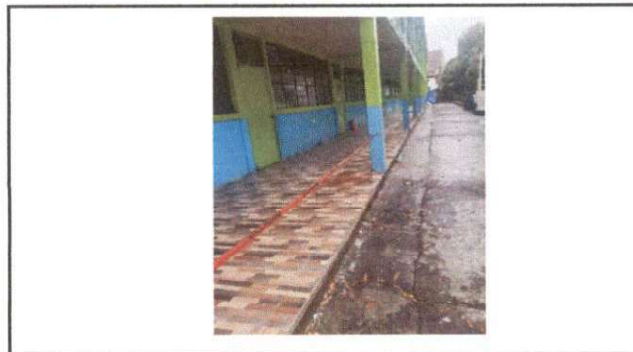
corredor del primer nivel
