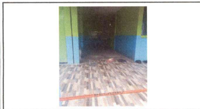
corredor del primer nivel
