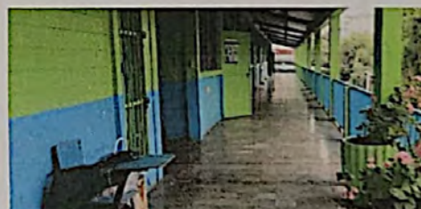
corredor del segundo nivel
