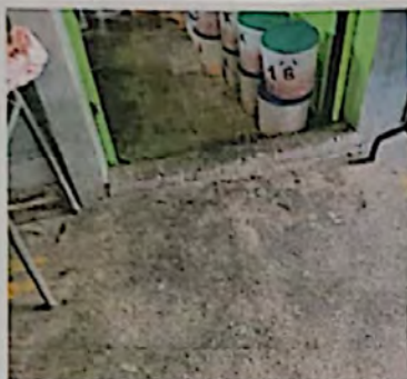
corredor del primer nivel
