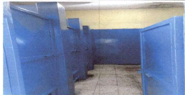
pintura actual de puertas de baños.
