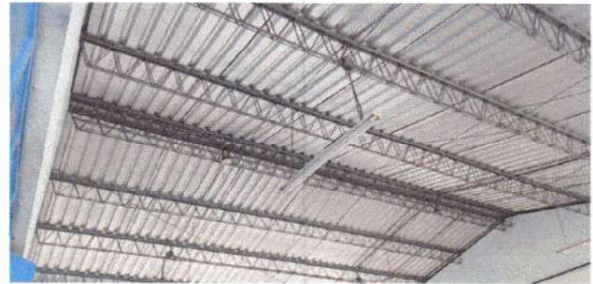
Instalación de techo.
