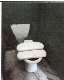
Desmontaje de sanitarios para limpieza.
