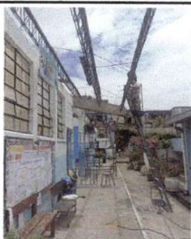
Desmontaje de techo pasillo Dirección.
