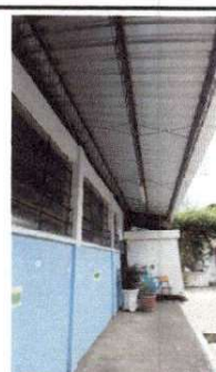
Montje de techo pasillo Dirección.
