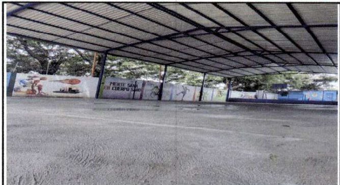
Foto 2: Loza recientemente fundida con elevación de 5 cms. y electro malla.
