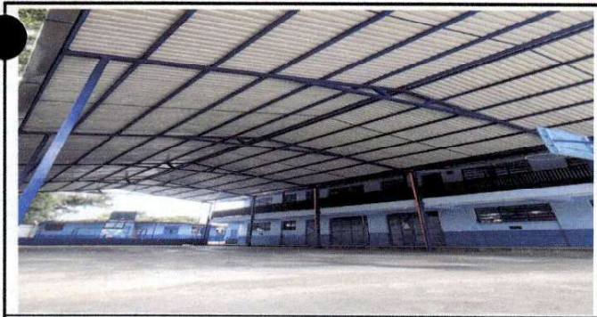
Foto 5: Imagen completa del trabajo de techado y mejoramiento de pavimento de cancha finalizados
