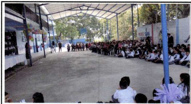
Foto 4: Lamina calibre 26 totalmente colocada sobre estructura de techo.
